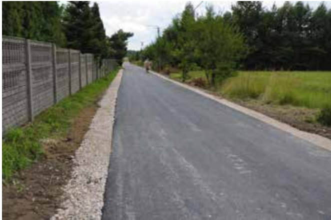
Pobocza zostały wzmocnione kruszywem. Ul. Bukowa.
