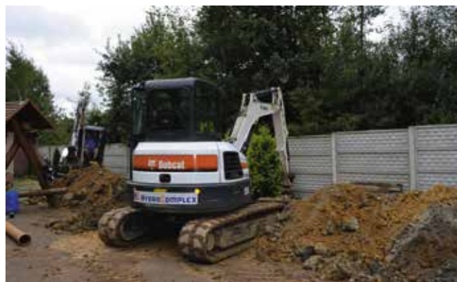
Budowa przyłącza gospodarstwa domowego w Ciekotach do sieci kanalizacyjnej.
