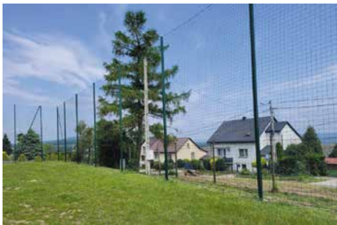
Piłkochwyty o długości 35 metrów i wysokość 6 metrów są wykonane z siatki i zamontowane na stalowych słupach.
