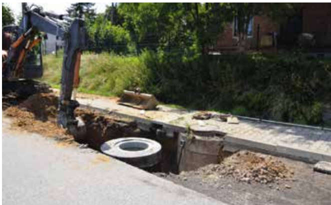
Na całej powierzchni drogi powstanie nowa warstwa ścieralna, a w miejscach zniszczonych przez wykopy kanalizacyjne zostanie odtworzona całkowita konstrukcja drogi.
