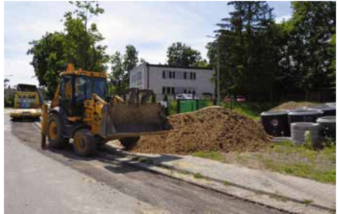
Po sfrozowaniu fragmentu jezdni trwają prace odwodnieniowe.
